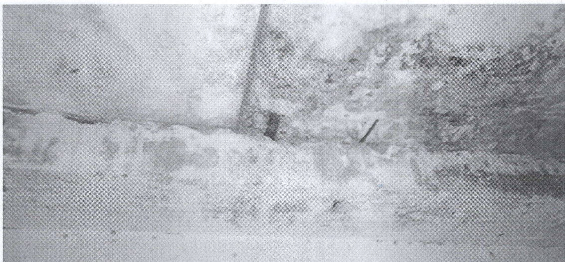
Foto 12. Lipsa stratului de protecție și ca rezultat coroziunea armăturilor dezgolate.
