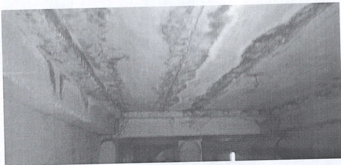
Foto 2. Mortarul de monolitizare a rosturilor dintre panourile de planșeu distrus și stratul de finisare interioară deteriorat.
