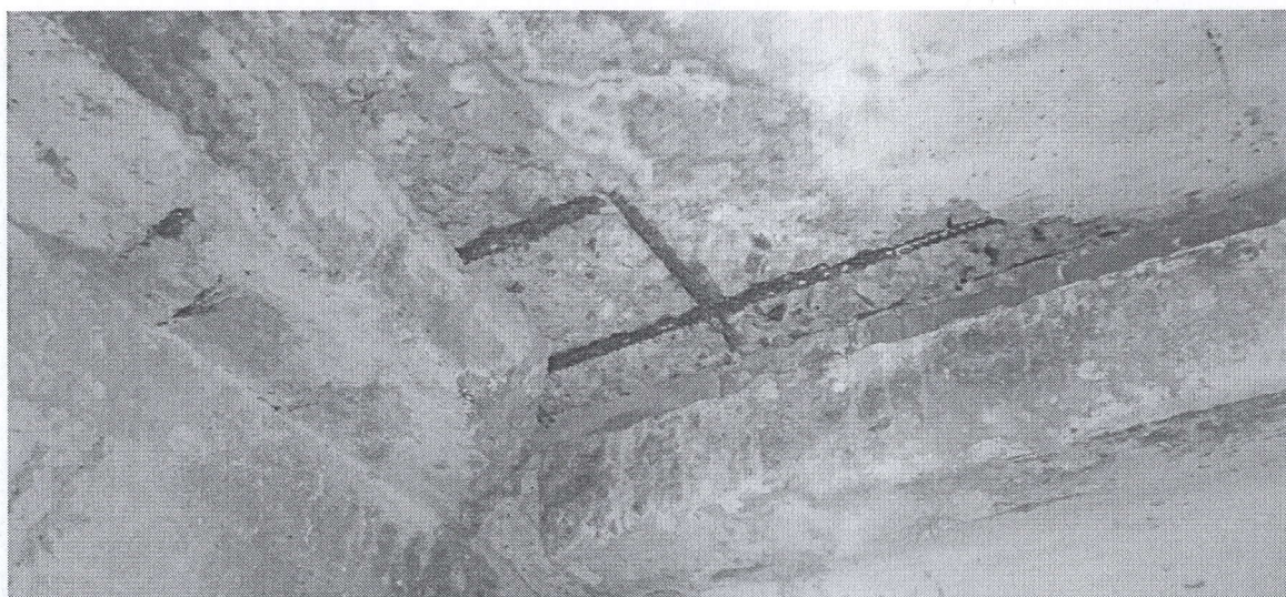
Foto 13. Lipsa stratului de protecție și ca rezultat coroziunea armăturilor dezgolate.
