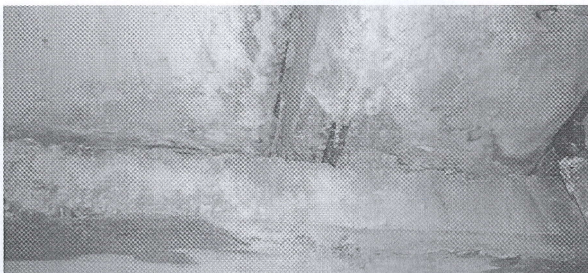
Foto 14. Lipsa stratului de protecție și ca rezultat coroziunea armăturilor dezgolate.
