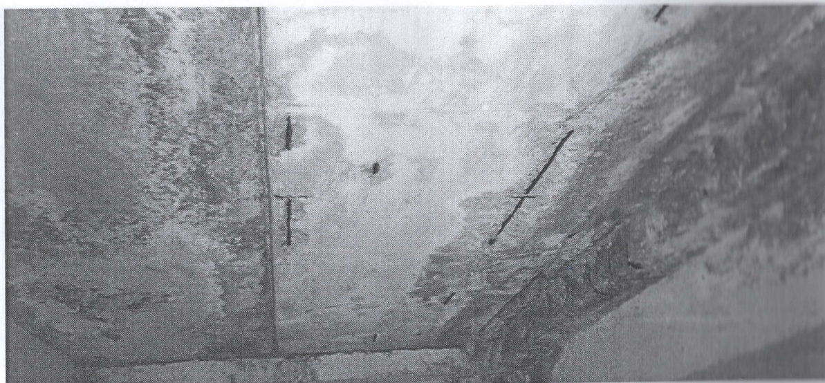
Foto 9. Lipsa stratului de protecție și ca rezultat coroziunea armăturilor dezgolate.
