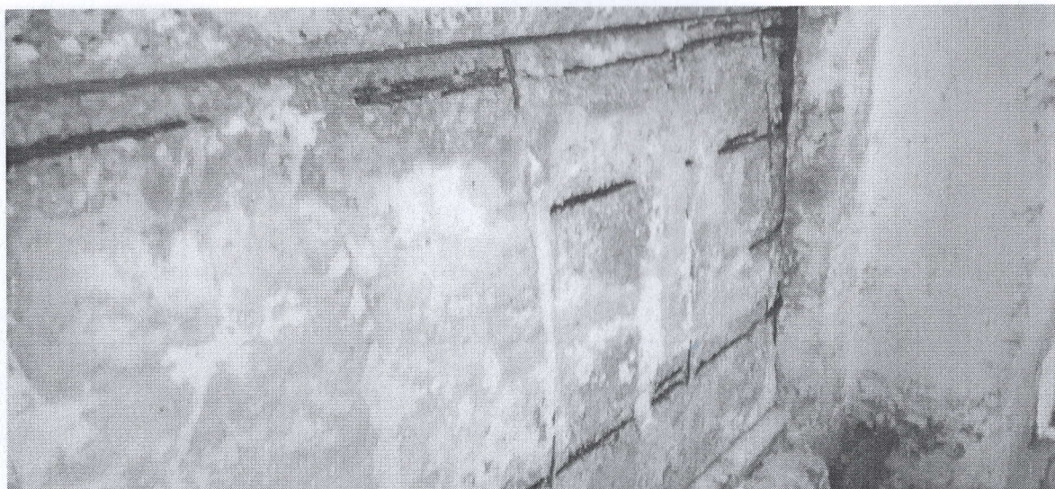
Foto 6. Lipsa stratului de protecție și ca rezultat coroziunea armăturilor dezgolate.
