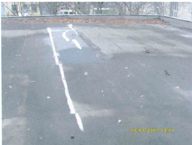
Anexa 6: Deformații/Inconveniențe alcătuire acoperiș - Blocul lit.M .
