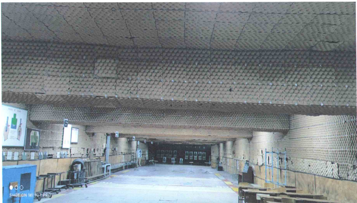
k: Anexa 16: Blocul lit.J (sală de sport) din cadrul complexului Academiei "Ștefan cel Mare" a MAI din str. Gh. Asachi, 21, mun. Chișinău.
