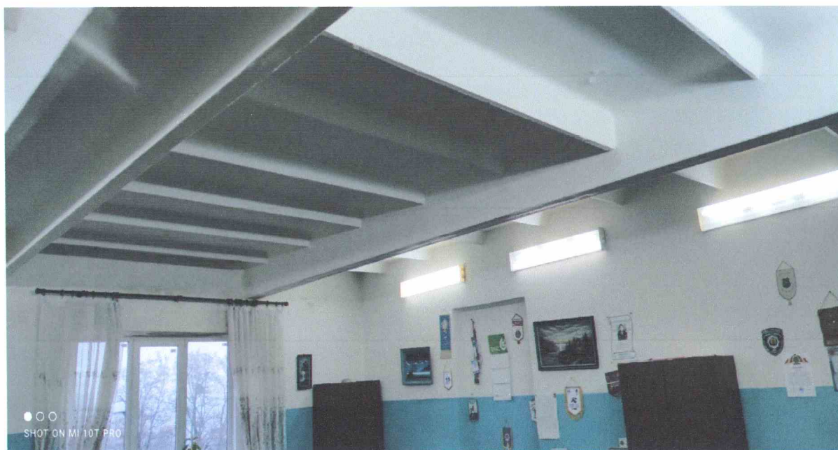
m: Anexa 16: Blocul lit.J (sală de sport) din cadrul complexului Academiei "Ștefan cel Mare" a MAI din str. Gh. Asachi, 21, mun. Chișinău.
