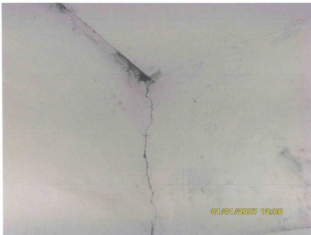
Anexa 9: Deformații (fisuri) în pereți cauzate de infiltrarea apelor pluviale/reziduale la nivelul fundațiilor - Blocul lit.M .
