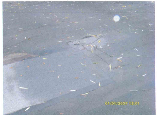
Anexa 6: Deformații/Inconveniențe alcătuire acoperiș - Blocul lit.M .
