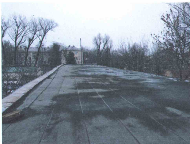
Anexa 21: Deformații/Inconveniențe alcătuire acoperiș - Blocul lit.J .
