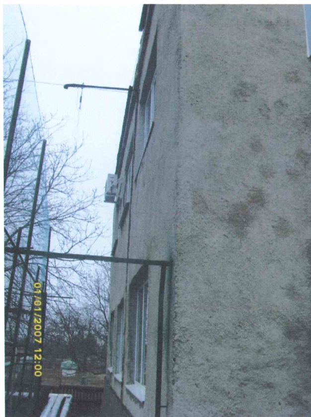
b: Anexa 16: Blocul lit.J (sală de sport) din cadrul complexului Academiei "Ștefan cel Mare" a MAI din str. Gh. Asachi, 21, mun. Chișinău.
