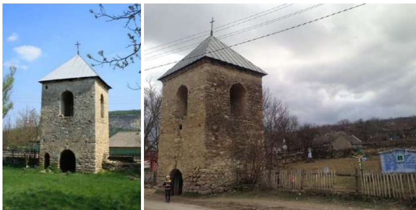
Рис. 124, 125. Смотровая (надвратная) башня Вадорашковского замка. Вид вид со двора и со стороны улицы
