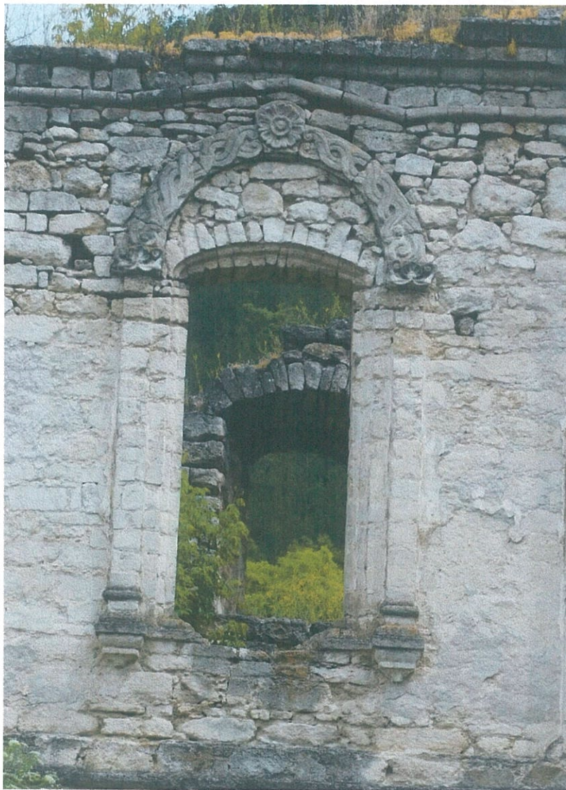
Обрамление боковых оконных проемов
